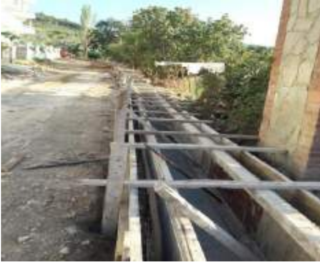
Karpuzdere Mahallesi, Bulut Sokak'ta heyelan bölgesine yapılan drenaj sularını toplayıp, Poyraz Caddesi'ndeki yağmur hattına verebilmek için 85 m'lik U kanalı yapılmıştır.
