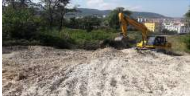
Ham Yol açımı Çamlık Mahallesi, 669. Sokak (147 m)
