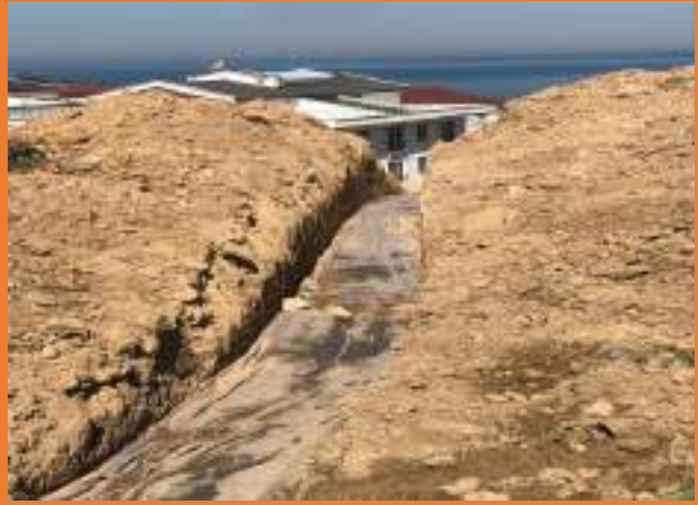
2019 Ağustos ayında yer altı sularını toplamak için Nato Yolu'nda şev sonundan başlayarak serbest kazı ile drenaj kanalları açıldı. Kanal dibine membran ve geotekstil keçe serilerek tozsuz 18-25 mm çapında taş kullanılarak doğal drenaj yapıldı. Böylece Poyraz Caddesi içerisinde bulunan yağmur kanalı drene edildi.
