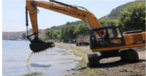
Yaz aylarında her gün, kış aylarında ise ihtiyaç dâhilinde belirli aralıklarla sahil mıntakası yapılmaktadır. Ayrıca düzenli aralıklarla kepçe ile yosun temizliği de yapılmaktadır.
