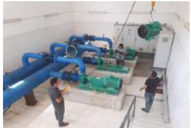
Kalıcı Konutlar İçme Suyu Terfi Merkezi'ndeki motorun mekanik arızası onarılmıştır.
