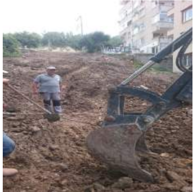
Harmanlar Mahallesi Orkide Sokak (30m)
