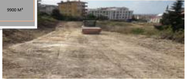
Ham Yol açımı Çamlık Mahallesi, 669. Sokak (147 m)
