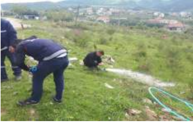
İlçe genelinde şantiye abone bağlantıları yapılmıştır.
