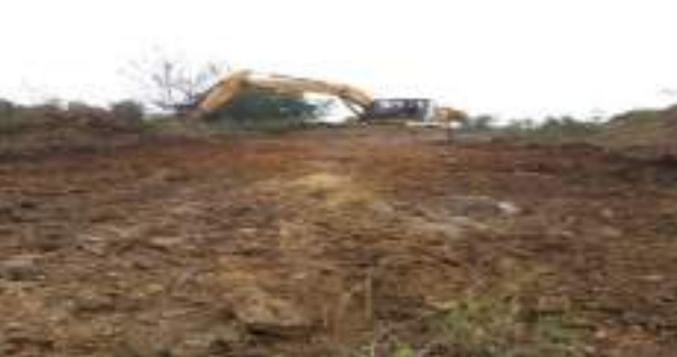
Ham Yol açımı Çalica, Çam Sokak (50 m)
