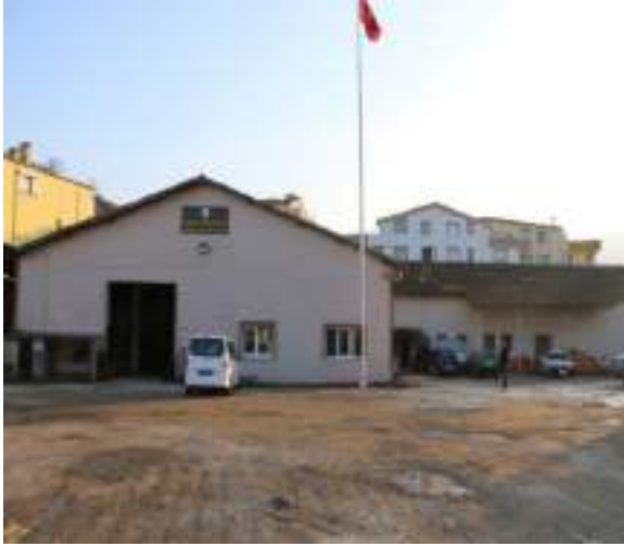
Ulaşım Hizmet Binası
