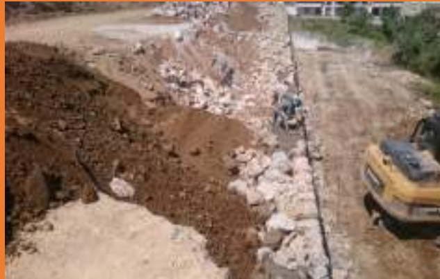
Poyraz Caddesi'nin içinden geçen bütün alt yapılar (yağmur hattı, kanalizasyon, su hattı ve Telekom alt yapısı) sökülerek, yeniden imalatları yapılmıştır.
