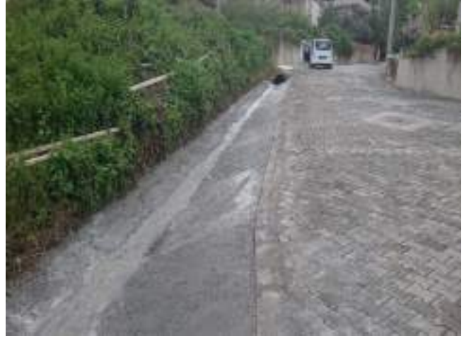
Kara Yolları ekipleri tarafından Yalova-Armutlu yolu üzerinde yapılan menfez, Harmanlar Mahallesi, Çaldıran 3 Sokak'a akmaktadır. Bu sebeple Çaldıran 3 Sokak'ta menfezden gelen suları, Poyraz Caddesi üzerinde bulunan yağmur hattına aktarabilmek için 159 m'lik V kanalı imalatı yapılmıştır.
