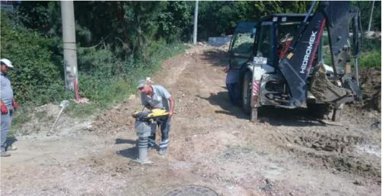
Harmanlar Mahallesi, Çaldıran 2 Sokak (100m) Yeni Kanalizasyon İmalatı
