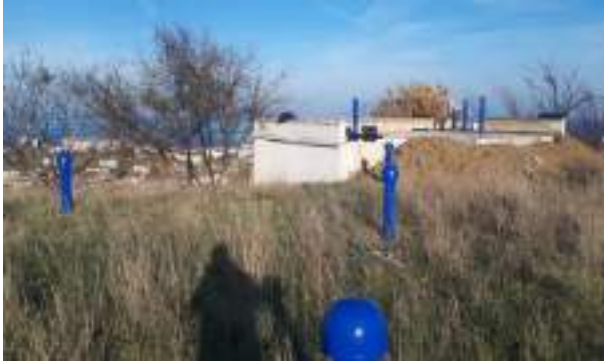
Kuru Terfi Merkezinin basma hattı ve havalandırma bacaların bakımı yapılmıştır.
