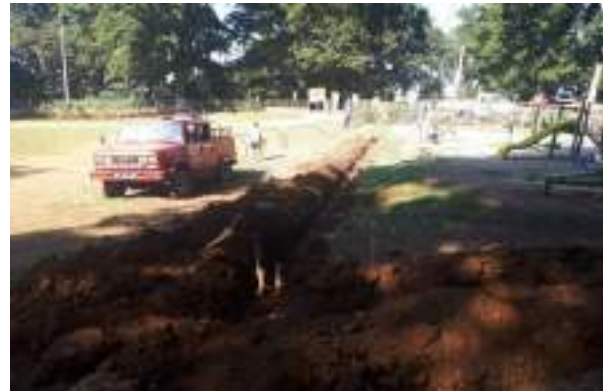
Hasanbaba Mesire Alanı'na yeni içme suyu hattı çekilmiştir.
