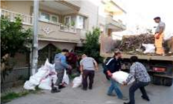
Bildirilmesi halinde, belediyeye yatırılan ücret karşılığında inşaat ve yıkıntı atıkları, belirtilen yerden, araçla alınmaktadır. Atık halini almış ev eşyaları (koltuk, kanepe, halı vb.) belirtilen yerden alınarak düzenli depolama sahasına götürülmektedir.
