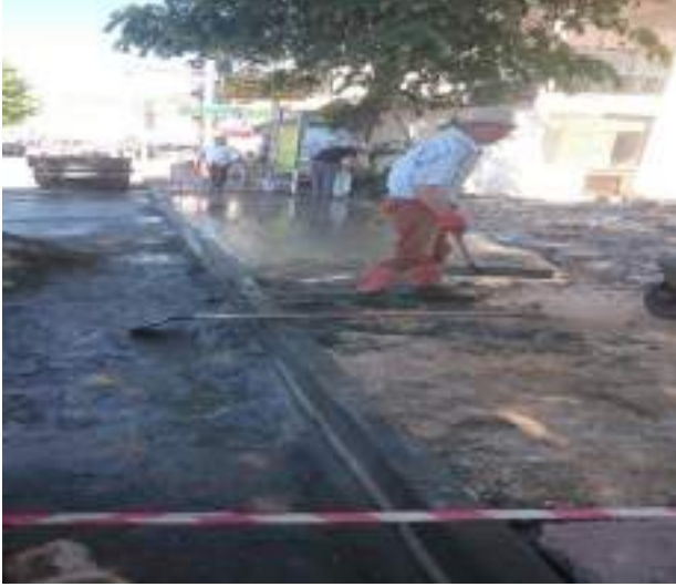
Kaldırım imalatı Harmanlar Mahallesi Vali Akı Caddesi
