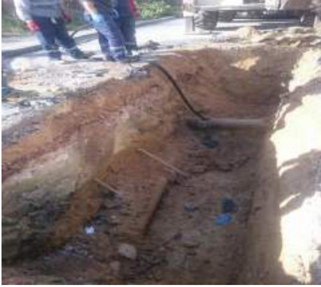
Mevcut kanalizasyon hatlarının onarımı yapıldı. Kullanımdan kaynaklı kanal tıkanıklıklarında, kanal aracının açamadığı durumlarda hat üzerinde lokal delik açılıp, bina ana hatta bağlantısı temizlenerek, onarımları yapıldı.
