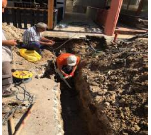
Telekom alt yapı ekipleri tarafından bina ana hatlarının tahrip edilen kısımları revize edilerek onarım işlemleri yapıldı.
