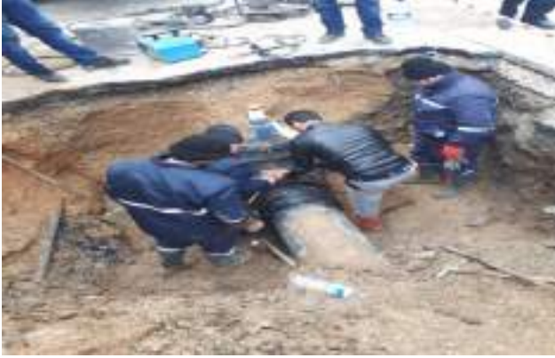
Poyraz Caddesi'ndeki \Phi 400 vananın manşon kısmındaki alın kaynağı arızası giderilmiştir.
