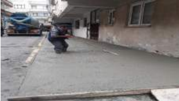
Kaldırım imalatı Harmanlar Mahallesi Ay Sokak
