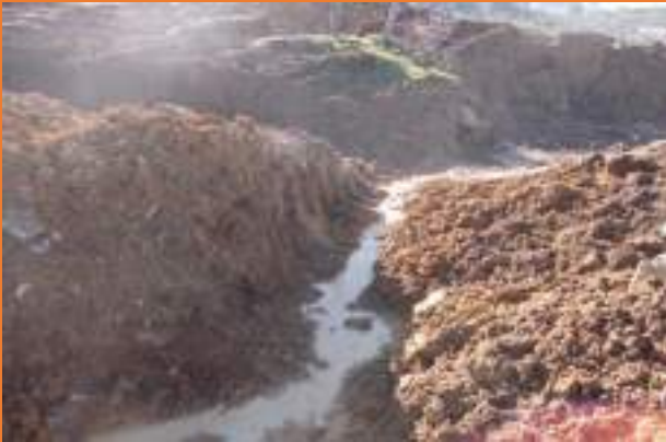
Yalova-Armutlu Nato Yolu'ndan başlayıp gelen yer altı sularının Poyraz Caddesi'ne toplanması.
