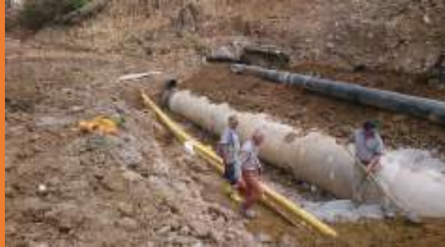
2019 Ağustos ayında yer altı sularını toplamak için Nato Yolu'nda şev sonundan başlayarak serbest kazı ile drenaj kanalları açıldı. Kanal dibine membran ve geotekstil keçe serilerek tozsuz 18-25 mm çapında taş kullanılarak doğal drenaj yapıldı. Böylece Poyraz Caddesi içerisinde bulunan yağmur kanalı drene edildi.
