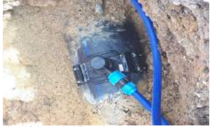
Kel Fuat Sokağa \Phi 315 HDPE abone bağlantısı yapılmıştır.
