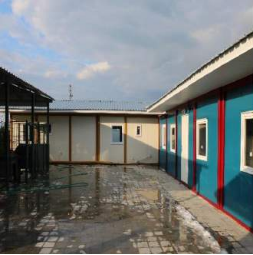
Veterinerlik Hizmet Binası
