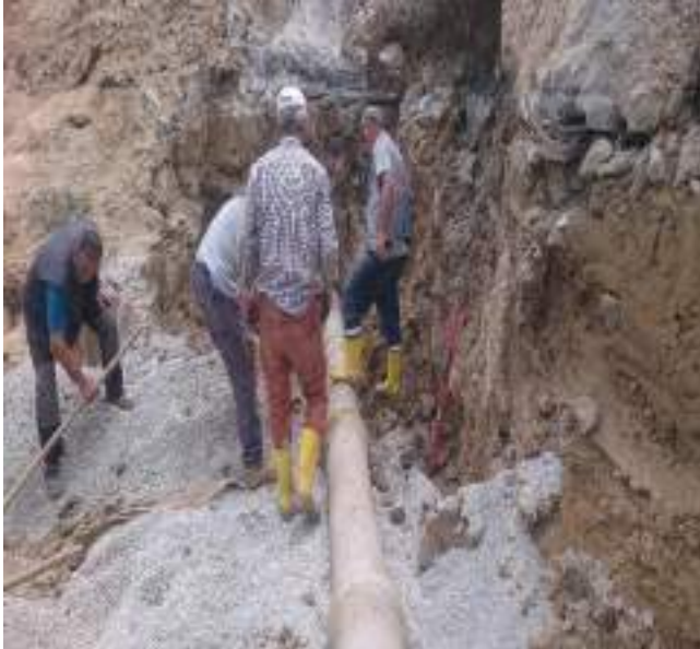
Poyraz Caddesi'nde meydana gelen heyelan nedeni ile kopan kanalizasyon hattının 40 m'lik kısmı yeniden yapıldı.
