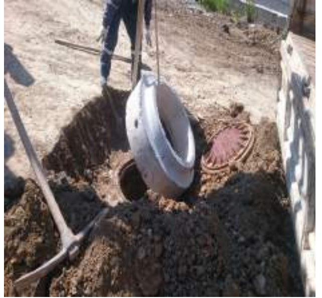
Mevcut muayene ve parsel baca kapakları revize edildi.
