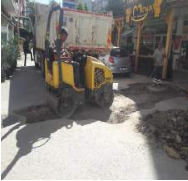
Bozulan yollarda Rotmix asfalt yama uygulamaları yapılmıştır.
