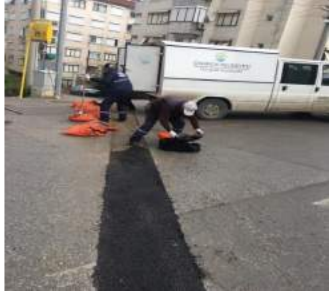
İhtiyaç duyulan yollarda poşet asfalt yama uygulamaları yapılmıştır.
