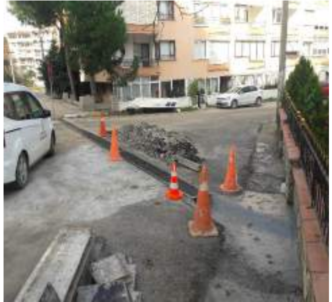
Karpuzdere Mahallesi, Kemer 2 Sokak'ta 15m'lik ızgara yapımı
