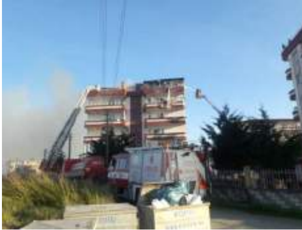
Kırılgaç Sitesi Kuru Bina Yangını (Daire ve Çatı)
