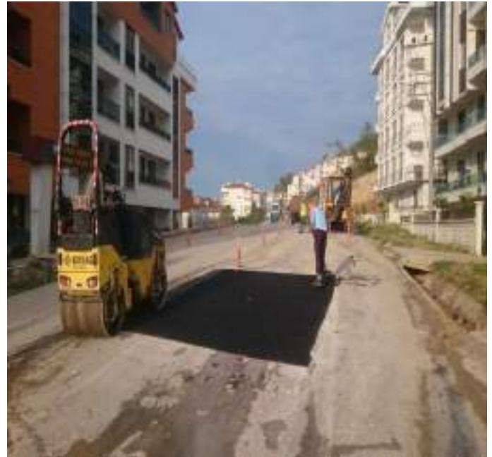
İlçe genelinde sıcak asfalt uygulamaları yapılmıştır.
