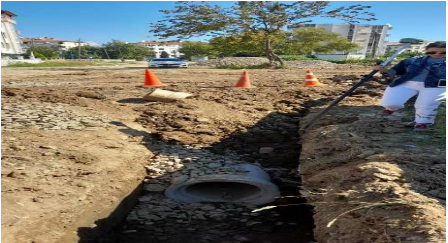
Karpuzdere Mahallesinde \varnothing 300 \varnothing apında yapılan yađmur hattı imalatı
