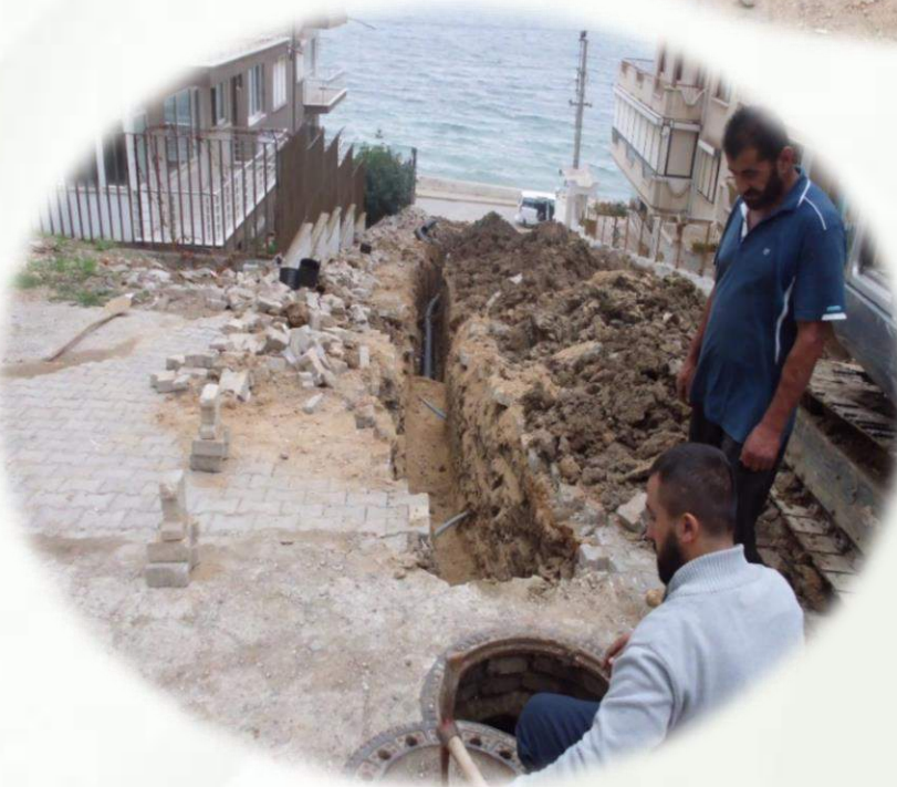
❖ Mevcut Kanalizasyon hatlarımıza ek olarak Toplamda 733 m yeni kanal yapılmıştır. Çınarcık ilçemizde Yapı Kullanma Belgesi alan 53 inşaatın, parsel bacalarından, ana hatlara bağlantı yapılmıştır.
