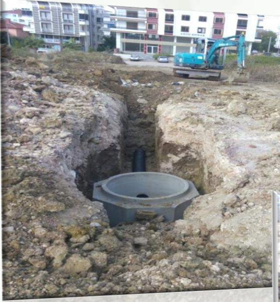
Harmanlar Mahallesi 255. Sokak'ta yapılan imalatlar
