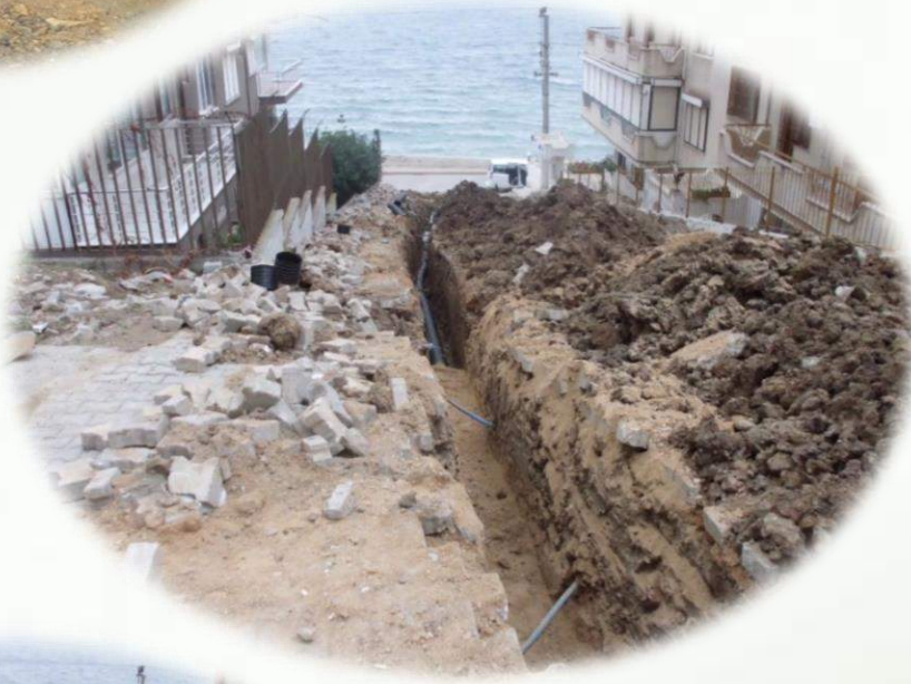
❖ Harmanlar Mahallesi Fulya sokak'ta 38 m Kanalizasyon hattı döşenmesi
