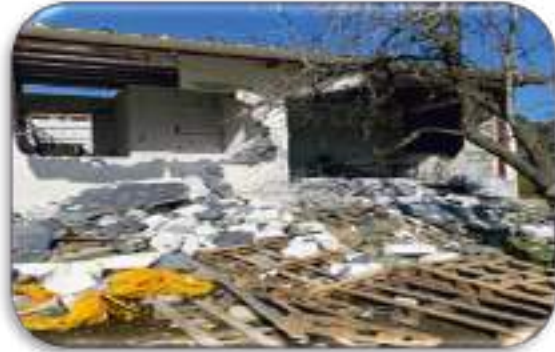
Şenköy Köyü kaçak yapı yıkımı
