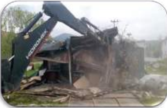
Hasanbaba Mahallesi kaçak yapı yıkımı
