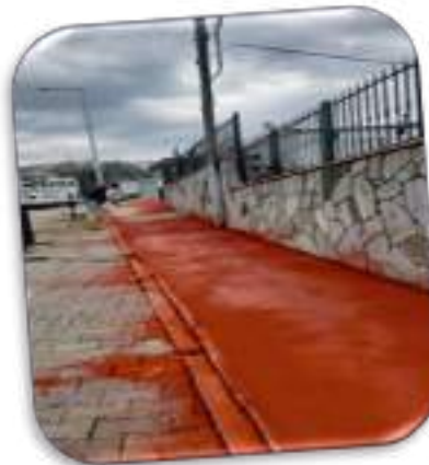
Taşlıman Mahallesi 414'üncü Sokak'ta baskı beton kaldırım imalatı yapılmıştır.
