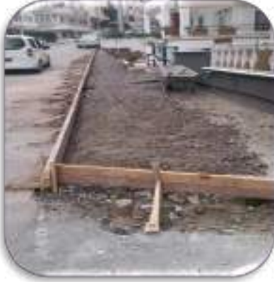
Harmanlar Mahallesi Orkide Sokak'ta beton kaldırım imalatı yapılmıştır.
